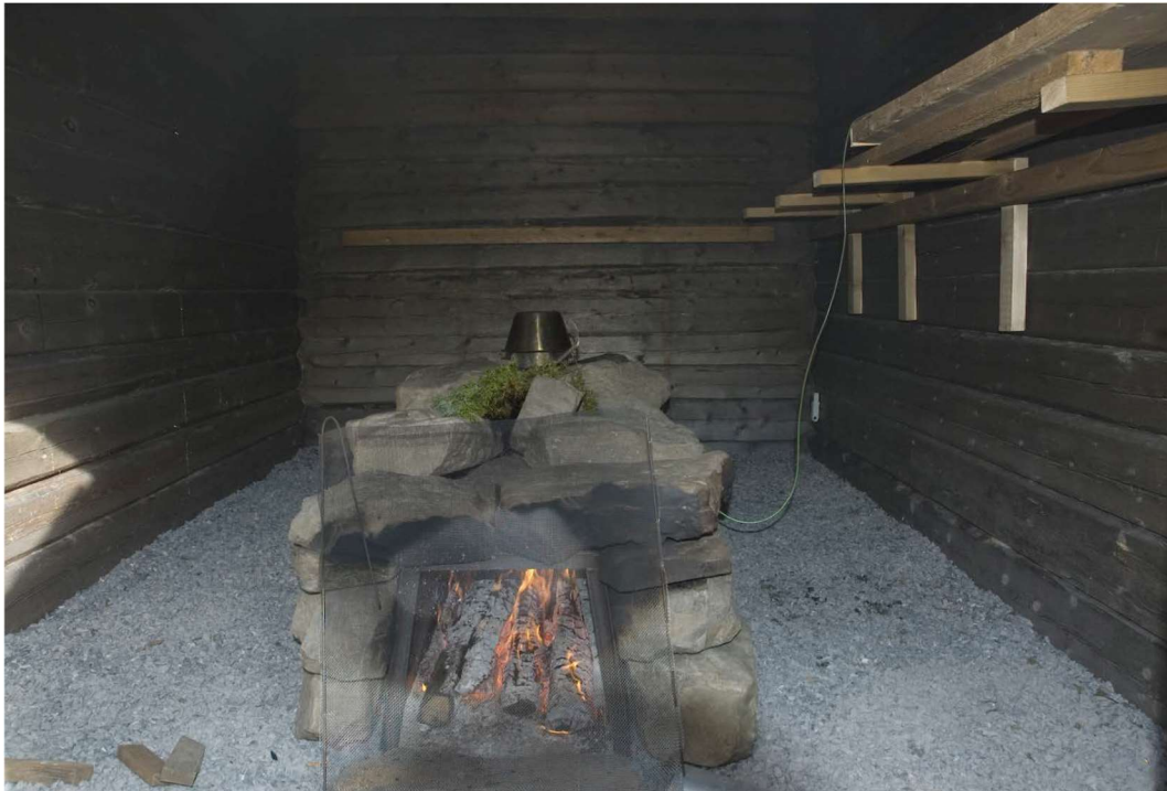
Bild 4. Eldstad och hyllor/upphängningsanordning i timrad rökbastu (för bild utifrån, se bild 3). Foto: Dag Hartman.
